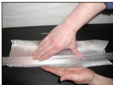
Kanten werden in Form gepresst
